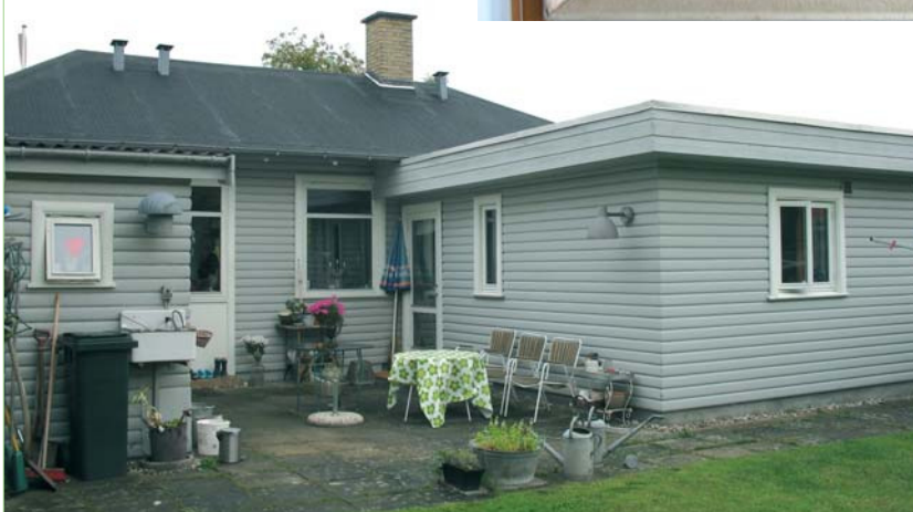
Bagsiden af huset med tilbygning og en hyggekgrog.
